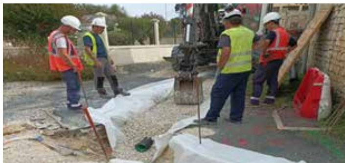
Pose du réseau pluvial avec tuyau drainant.
