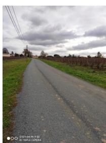
Route du Crochet Reprofilage général en grave émulsion + enduit monocouche
