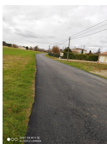
Chez les Roux Réfection de la couche de roulement
